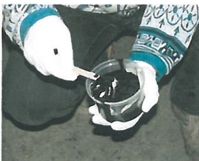
Mieszanie żywic epoksydowych.
