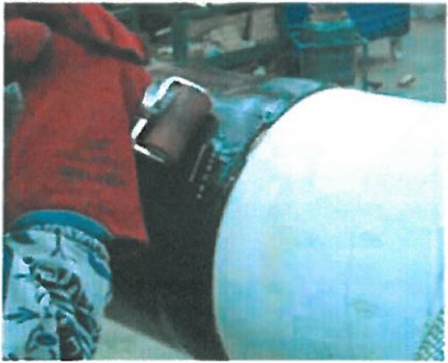
Wygladzanie wałkiem powierzchni okolice listwy zamykającej.
