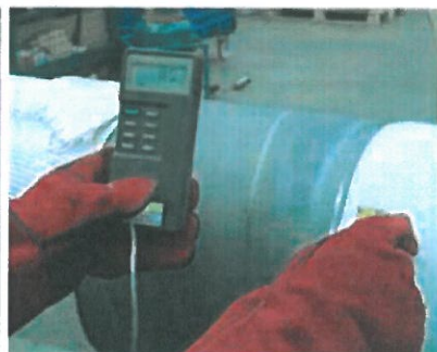
Sprawdzanie temperatury podgrzewania na PP (80°C-90°C) lub (176°C-194°F).
