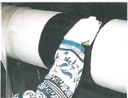
Nakładanie żywic na stal.
