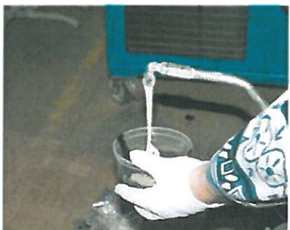
Dozowanie żywicy epoksydowej S1301-M lub S1401 - część A lub użycie wcześniej przygotowanych zestawów epoksydowych.
