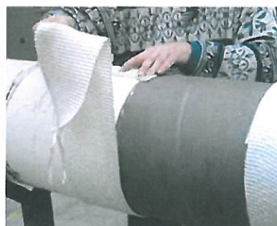
Nakładanie osłon termicznych na powłokę PP.
