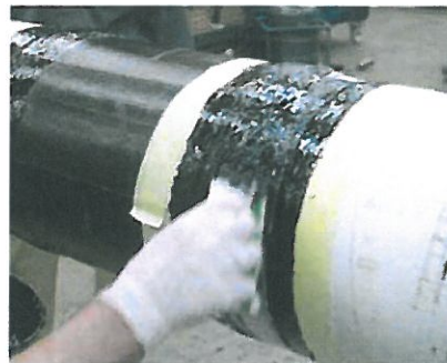
Aplikacja zewnętrznej warstwy żywicy epoksydowej. Nagrząć żywicę epoksydową do temperatury 50-60 ° C, tak aby uzyskać twardość 70 D po około 1,5 godziny.
