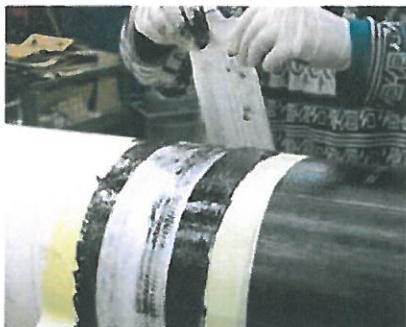
Nakładanie siatki z włókna szklanego na pierwszą warstwę żywicy epoksydowej.
