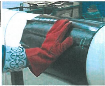
Montaż listwy zamykającej.
