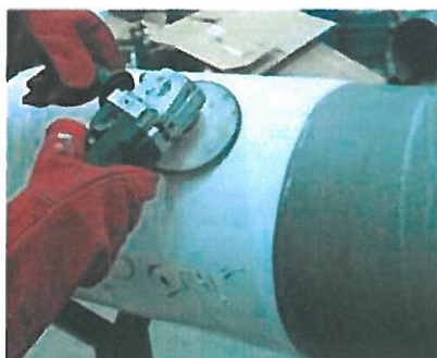
Czyszczenie i fazowanie PP za pomocą ściernicy P24 lub P36 / Min szerokość czyszczenia = szerokość rękawa + 100 mm (4 ").
