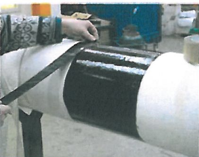
Nakładanie paska klejącego na powłokę PP. Upewnić się, że szerokość kleju jest taka sama, jak szerokość zakładki na powłoce liniowej PP.
