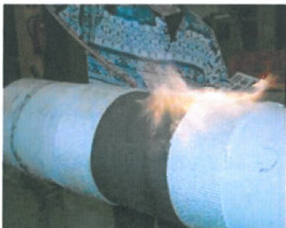
Wstępne podgrzewanie stali i powlekanie liniowe PP.
